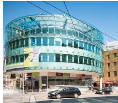
Zentrum Rennweg, Wien (Österreich)
