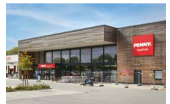
Einzelhandel Hochfelder Landstraße Flensburg
