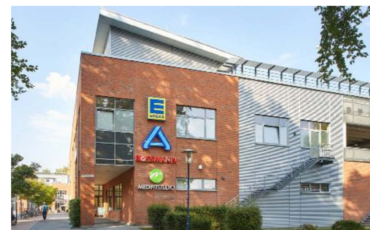
Zentrum Rennweg, Wien (Österreich)
