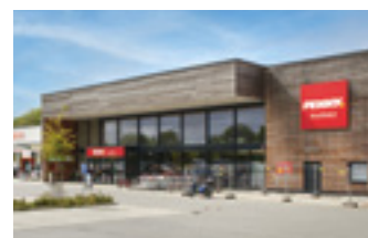
Einzelhandel Hochfelder Landstraße Flensburg
